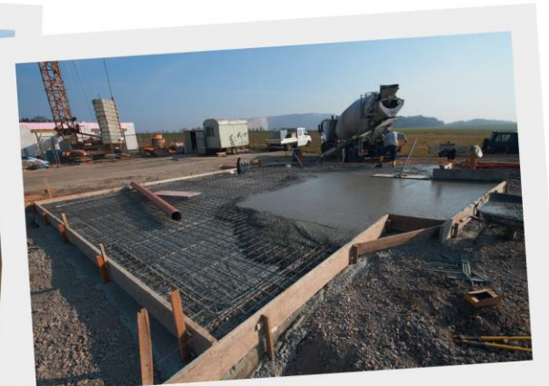
Die Fundamentplatte wird mit Zement ausgegossen.
