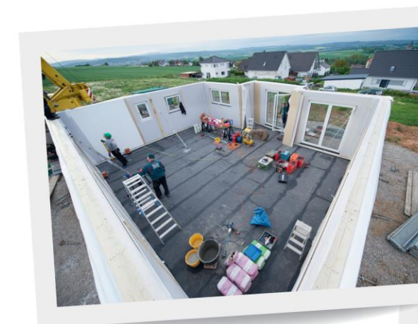
Nach zwei Stunden steht bereits das Erdgeschoss.
