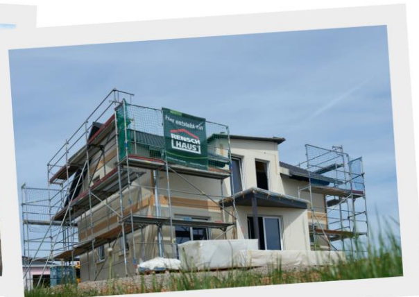
Schon nach zwei Tagen ist der Aufbau abgeschlossen.
