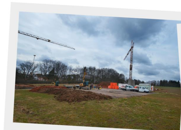
Der Baugrund muss zuallererst eingeebnet sein.
