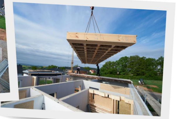
Mit dem Kran schwebt die Holzbalkendecke herein.
